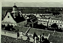
5. De Fortkerk gezien vanaf het dak van het K.N.S.M.-gebouw.
