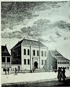
21. De oude Lutherse kerk, die in 1762 was gesticht en later in vlammen is opgegaan. (17 Februari 1804).
